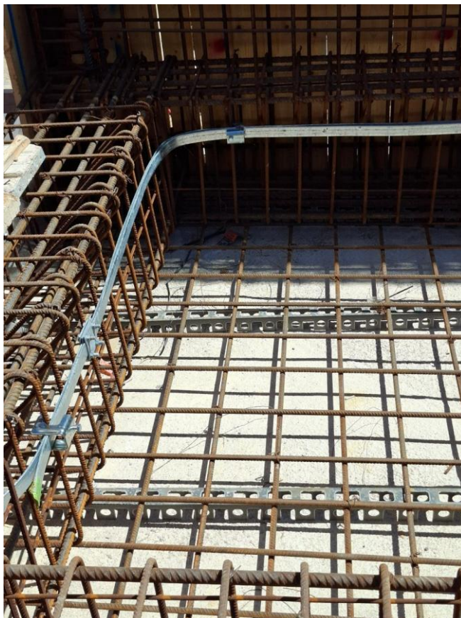
Φωτογραφία 2. Θεμελιακή γείωση σε πλάκα γενικής κοιτόστρωσης (ραντιέ): αλλαγή κατεύθυνσης της γαλβανισμένης ταινίας και σύνδεσή της με τον οπλισμό πριν από τη σκυροδέτηση.
