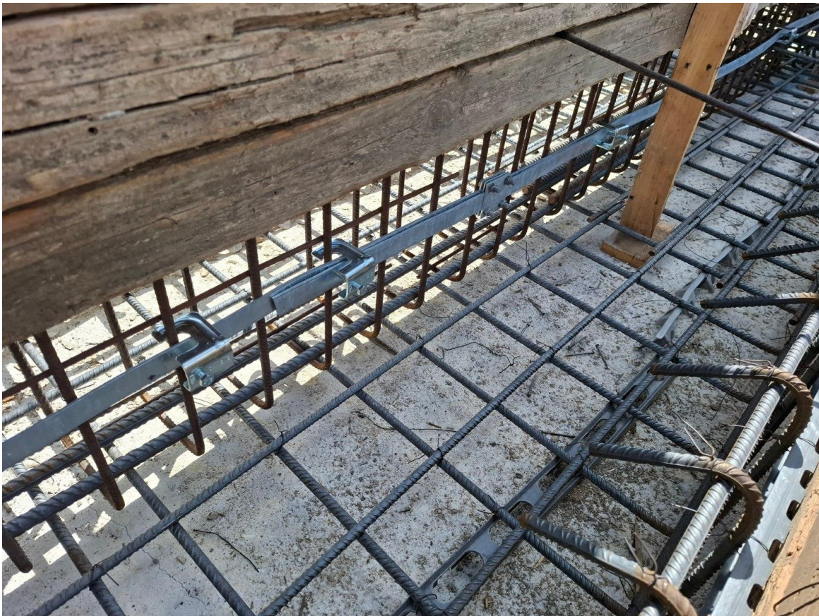
Φωτογραφία 4. Κοντινή λήψη ειδικών μεταλλικών σφιγκτήρων που στερεώνουν και συνδέουν τη γαλβανισμένη ταινία στον οπλισμό.
