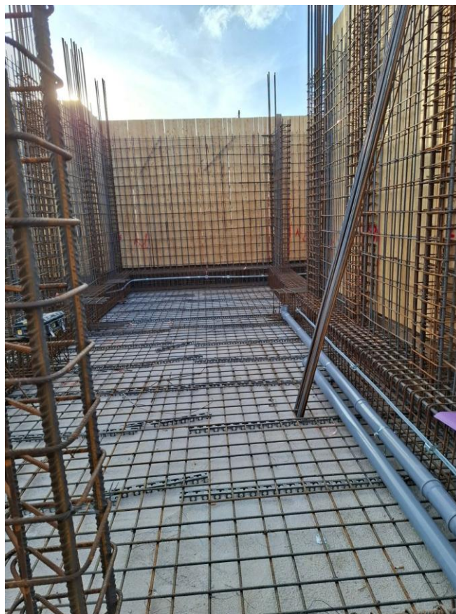
Φωτογραφία 1. Γενική εικόνα οπλισμένης θεμελίωσης πριν από τη σκυροδέτηση. Η θεμελιακή γείωση εντάσσεται στον σχεδιασμό του οπλισμού από τα πρώτα στάδια του έργου.
