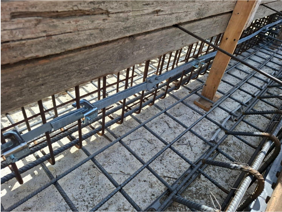
Φωτογραφία 5. Κοχλιωτός σύνδεσμος δύο τμημάτων γαλβανισμένης χαλύβδινης ταινίας, σε συνδυασμό με στηρίγματα οπλισμού.
