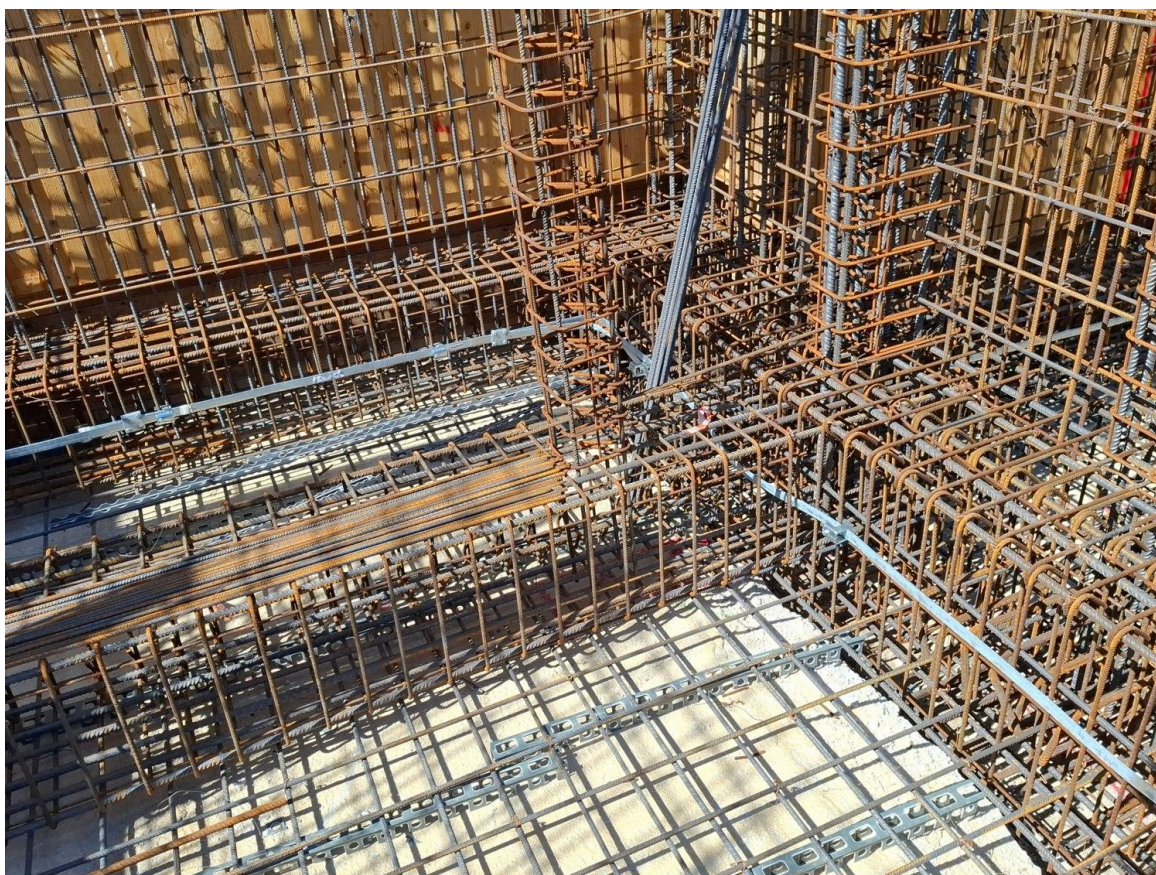
Φωτογραφία 3. Εκτεταμένη όδευση της θεμελιακής ταινίας κατά μήκος οπλισμένης θεμελίωσης, με διαδοχικούς σφιγκτήρες σύνδεσης.
